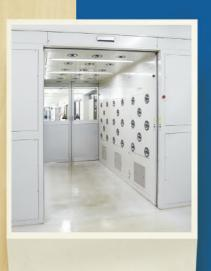
虫などの異物が工場内へ侵入するのを防ぐため、すべての工場の出入り口にエアシャワー・エアフェンスを設けるほか、物流搬入口の二重構造化や工場全体の無窓化など、万全の防虫対策を徹底しています。また、工場内部の気圧を高めて外気の流入を防ぐ陽圧化の取り組みを進めています。
